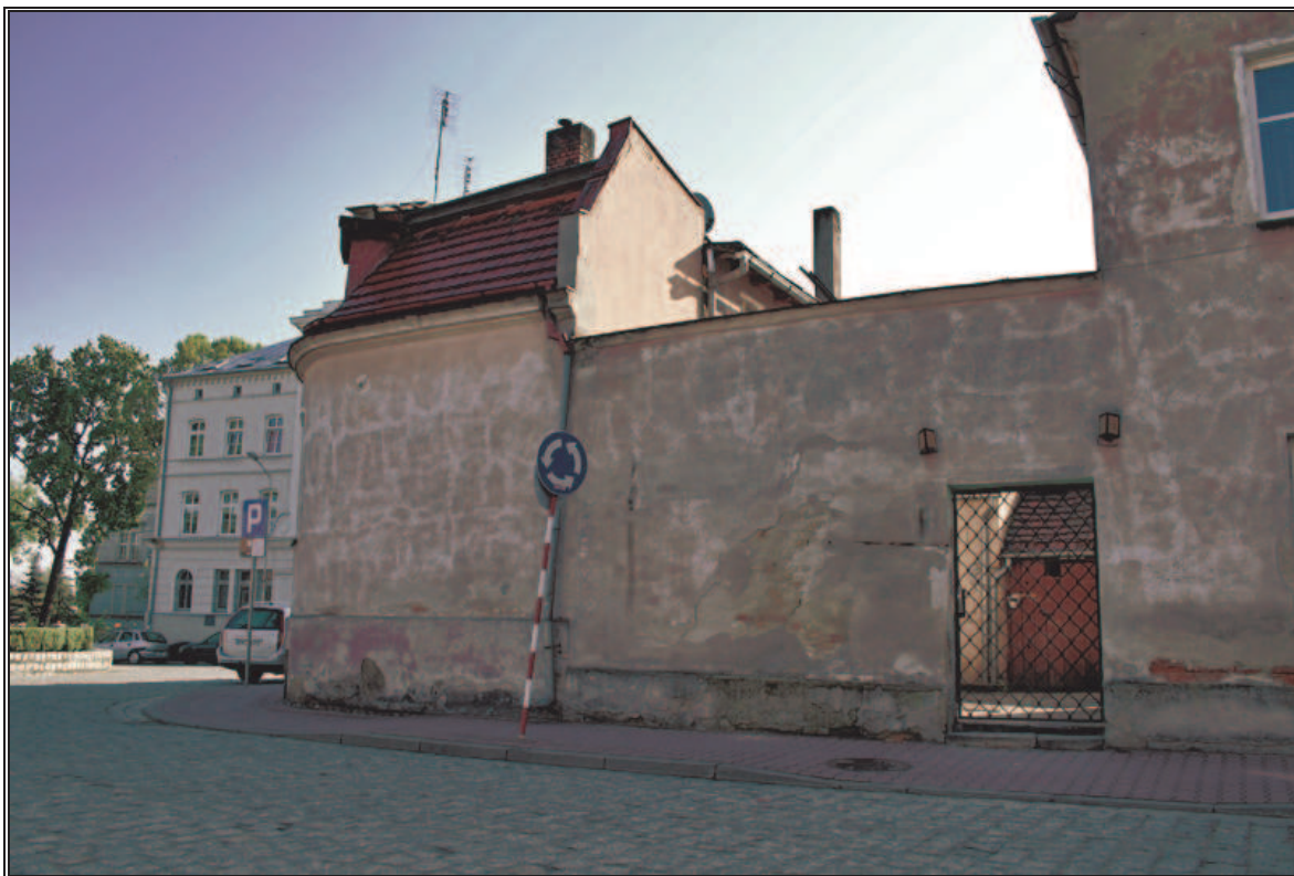
Fot. 20 i 21 Budynek przy Placu Sobieskiego 9.
