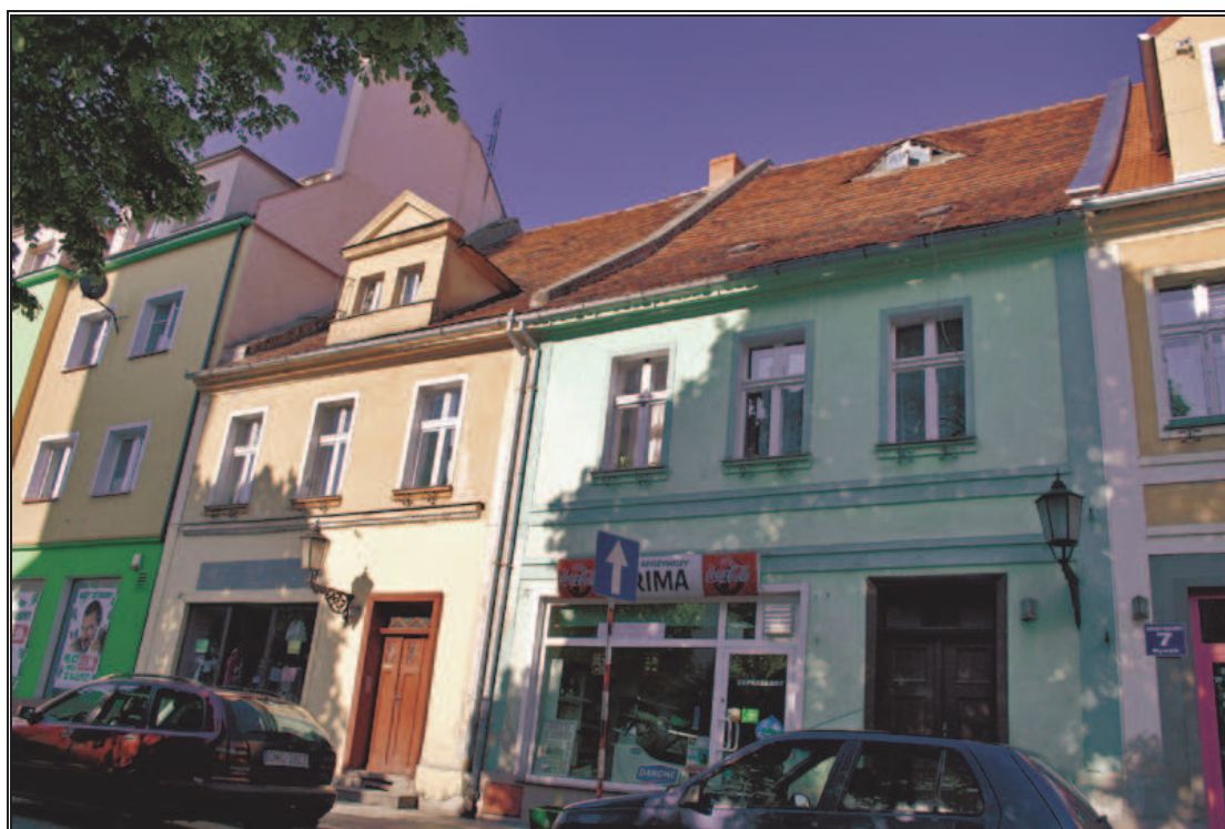
Fot. 13. Budynek przy ul. Rynek 5-6.
