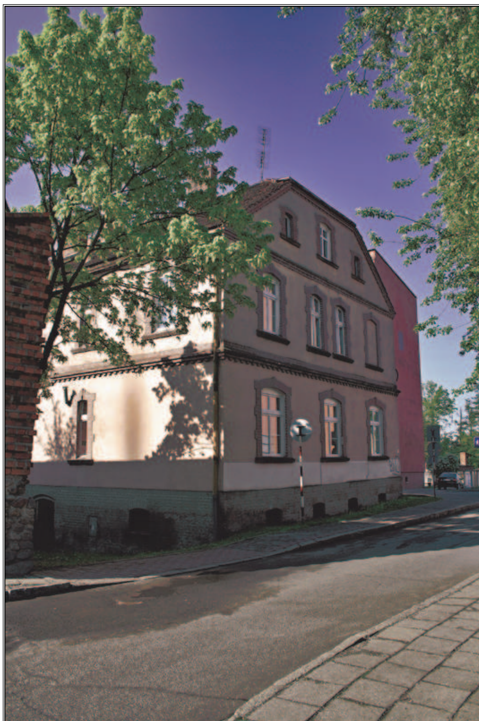
Fot. 11. Budynek przy ulicy Korzeniowskiego 5.
