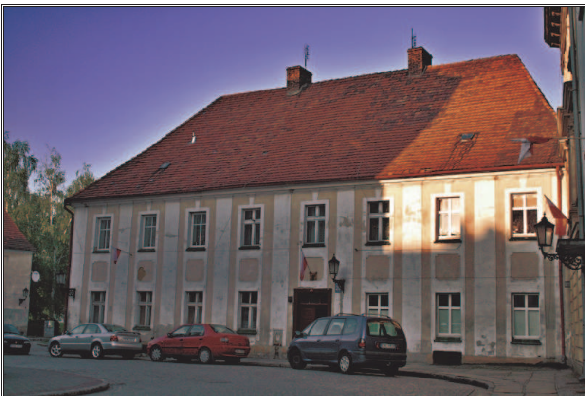
Fot. 18. Budynek mieszkalny przy ul. Wrocławskiej 20.
