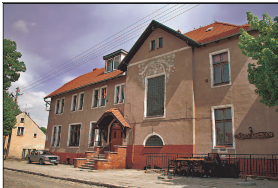
Fot. 2. Budynek Wołowskiego Ośrodka Kultury, przy ul. Sikorskiego. (Widok z przodu)
