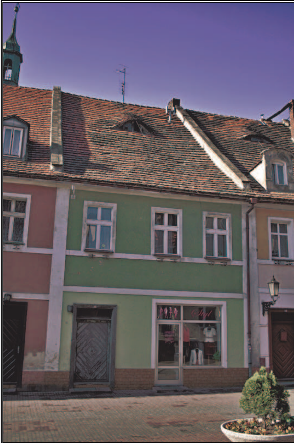
Fot. 14. Budynek przy ul. Piastów Śląskich 26.
