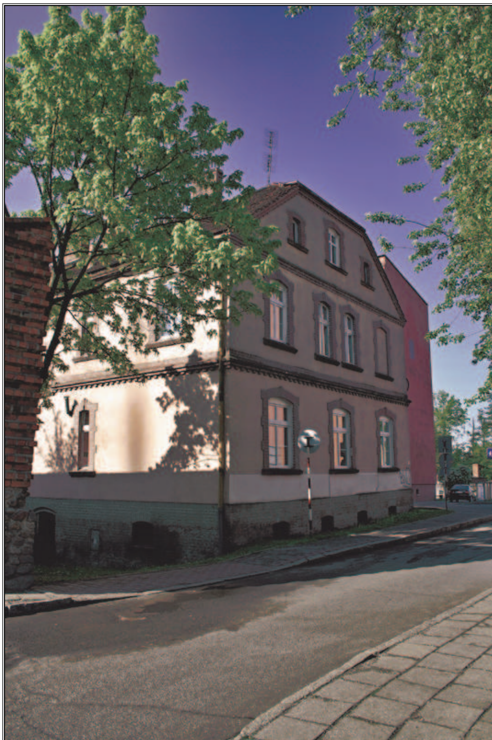
Fot. 11. Budynek przy ulicy Korzeniowskiego 5.
