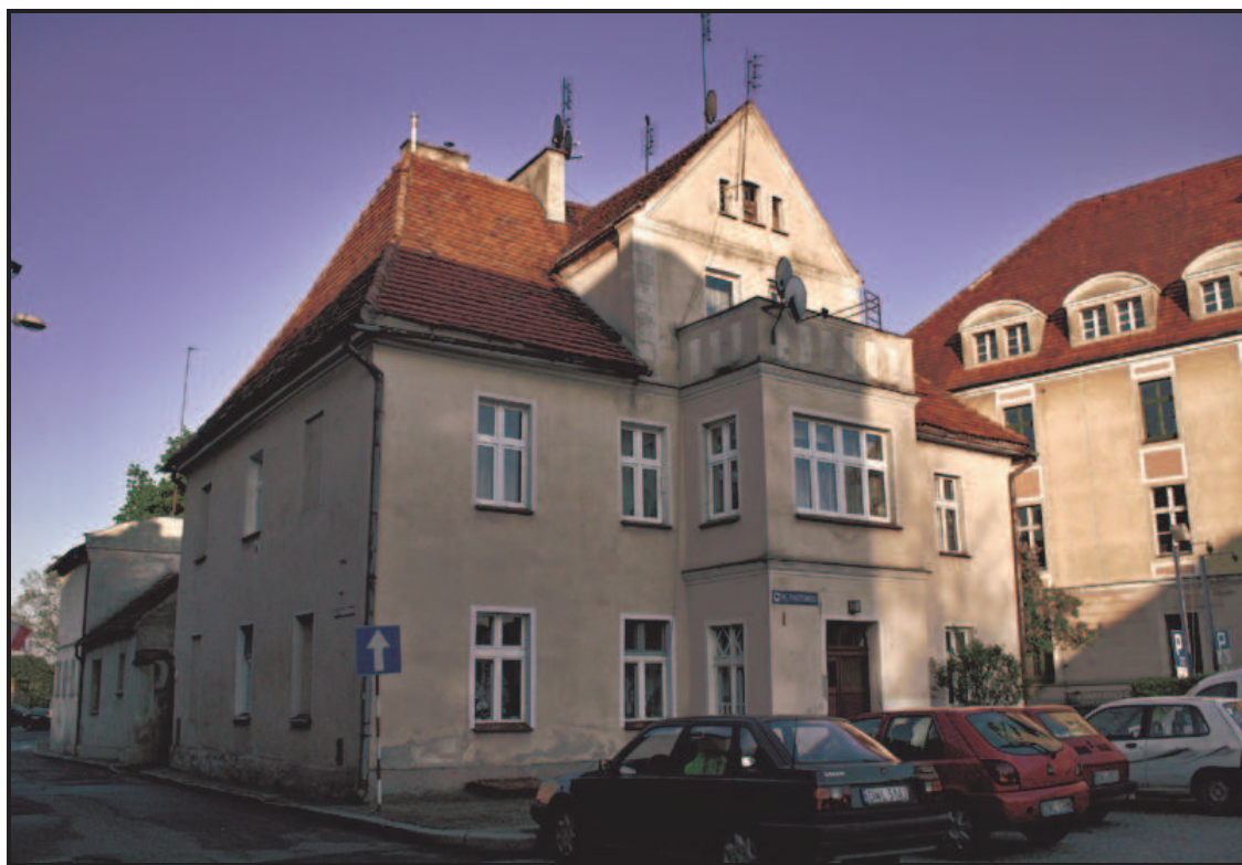
Fot. 12. Budynek przy Placu Piastowskim 1.
