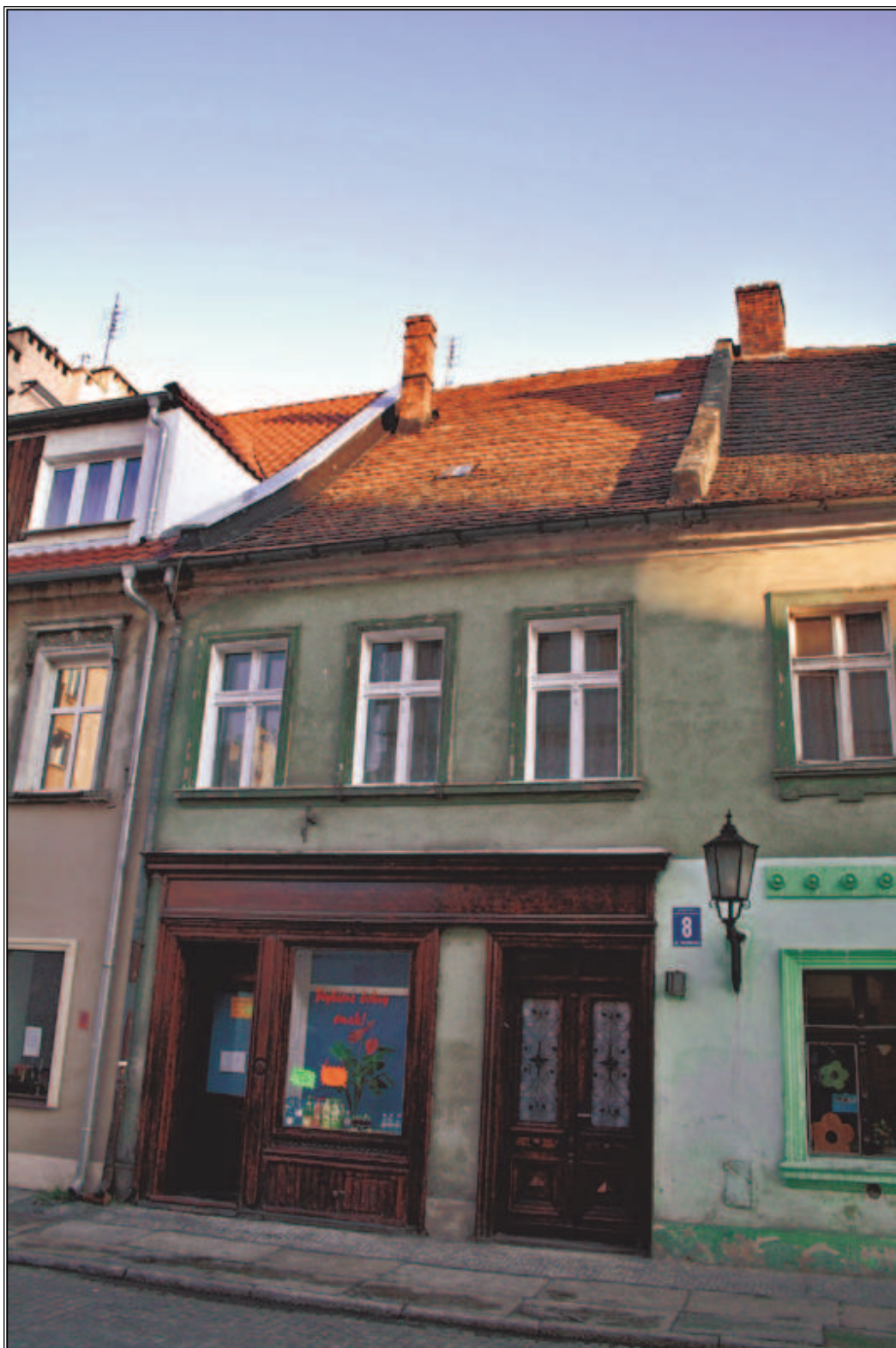
Fot. 19. Budynek przy ul. Wrocławskiej 8.
