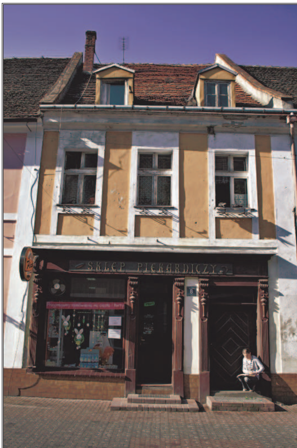
Fot. 16. Budynek przy ul. Piastów Śląskich 8.
