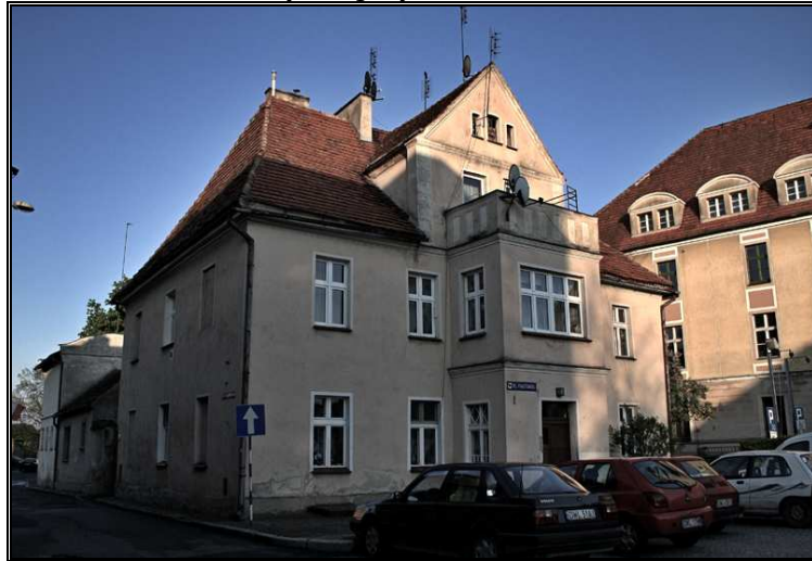
Fot. 12. Budynek przy Placu Piastowskim 1.
