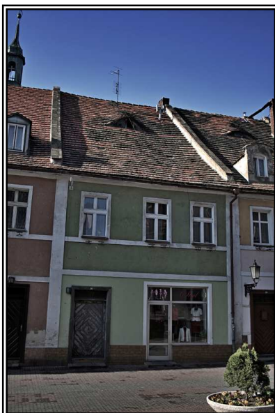
Fot. 14. Budynek przy ul. Piastów Śląskich 26.
