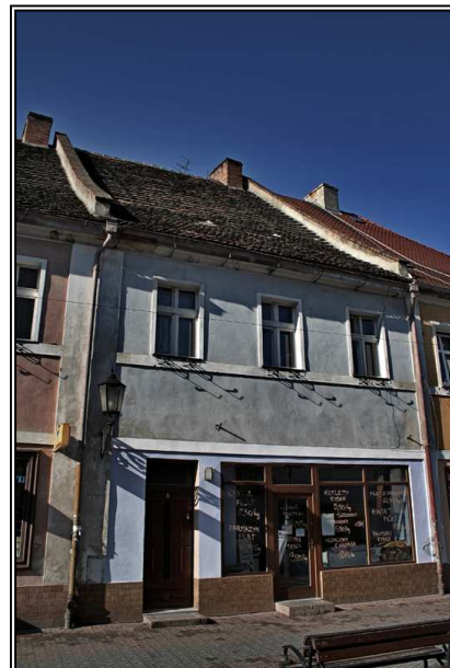
Fot. 15. Budynek przy ul. Piastów Śląskich 4.
