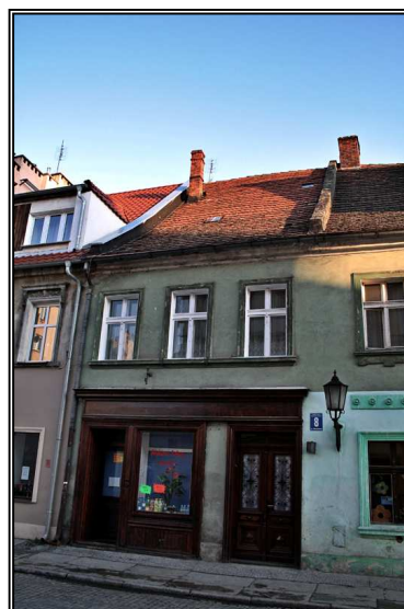
Fot. 19. Budynek przy ul. Wrocławskiej 8.
