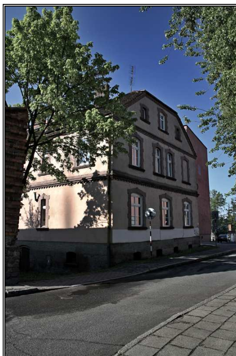
Fot. 11. Budynek przy ulicy Korzeniowskiego 5.
