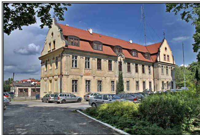
Fot. 17. Budynek Komendy Powiatowej Policji w Wołowie, przy ul. Piłsudskiego.
