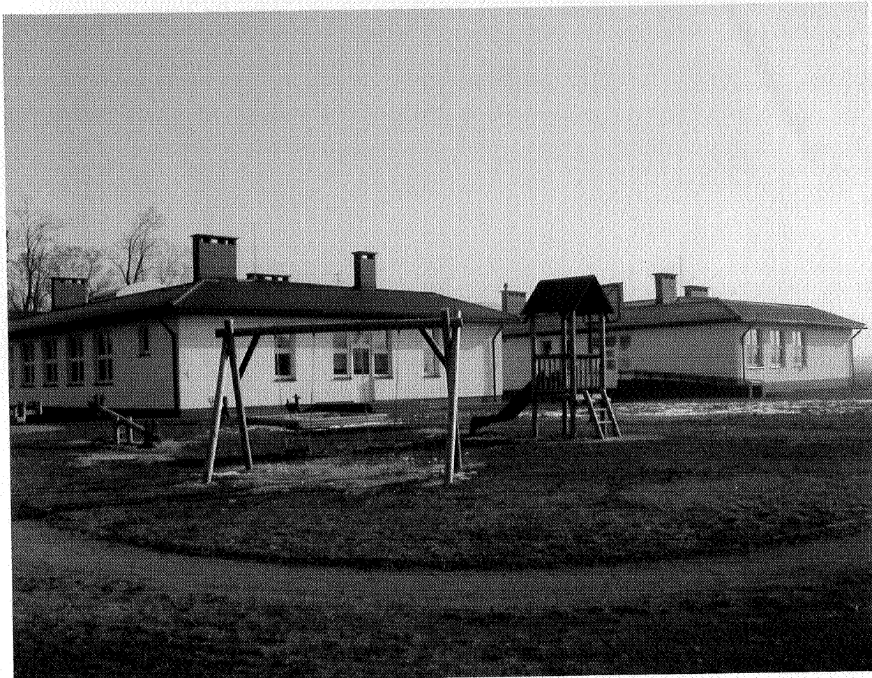
3. Widok szkoły od miejsca dobudowy stan 03 2005.
