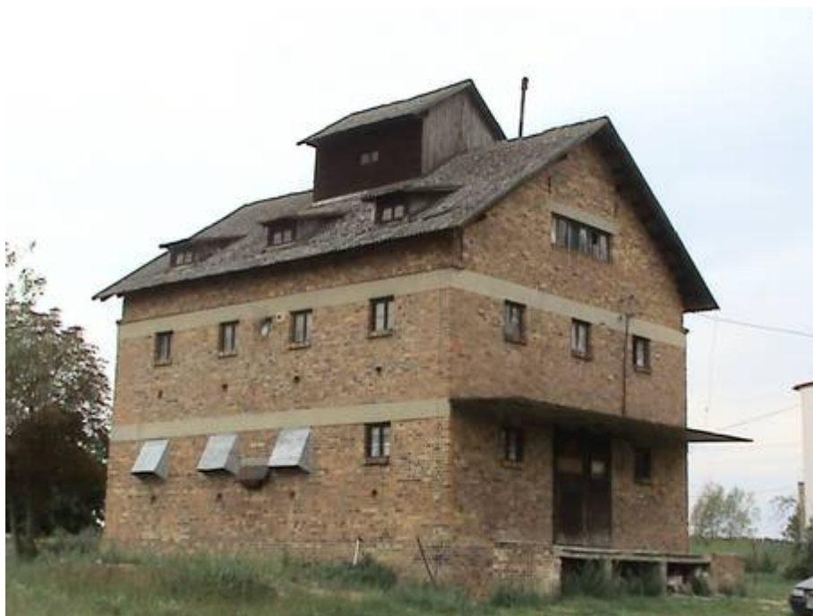
Fot. 7. Budynek, w którym prowadzona jest działalność gospodarcza - Łososiowice.
