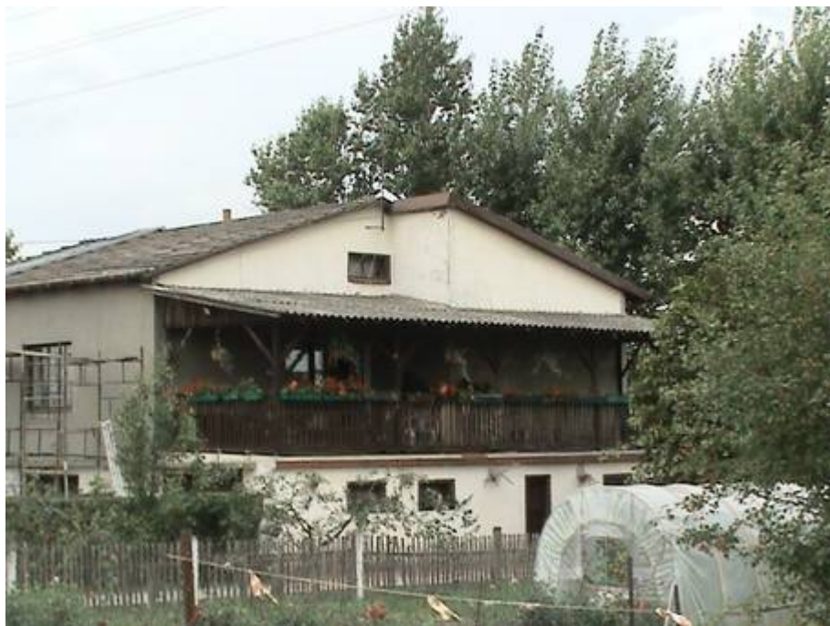
Fot. 4. Budynek mieszkalny pokryty płytami azbestowymi (Wołów, ul. M. Skłodowskiej-Curie 36).
