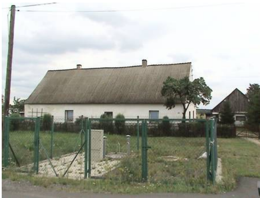
Fot. 9. Budynek mieszkalny pokryty płytami cementowo-azbestowymi – Łososiowice nr 13.
