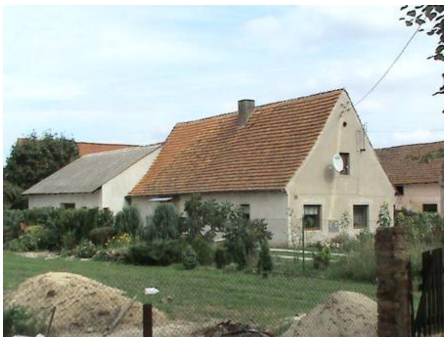
Fot. 5. Budynek gospodarczy pokryty płytami azbestowymi – Piotroniowice nr 26.
