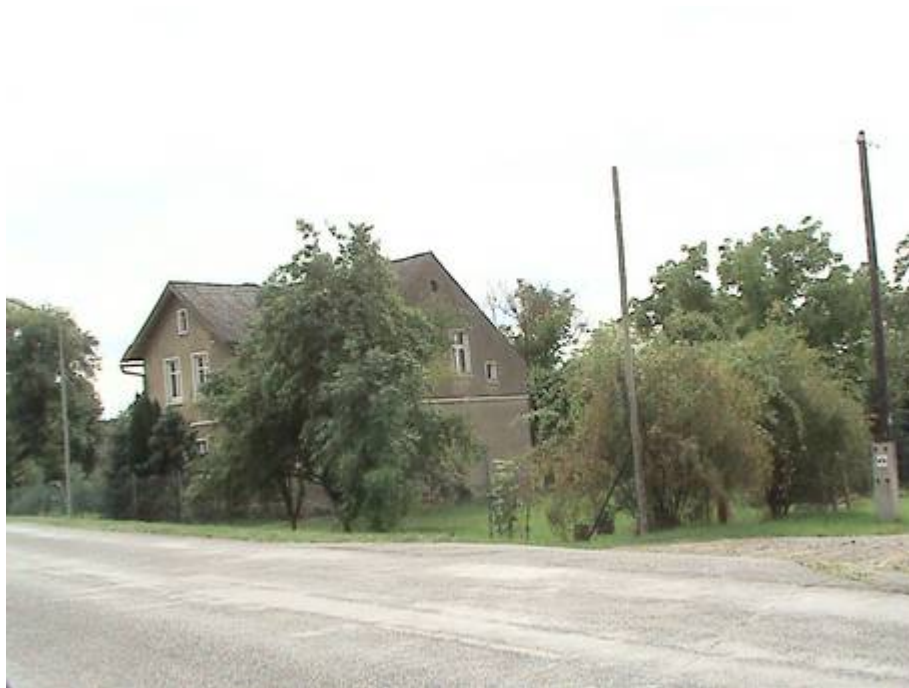
Fot. 8. Budynek mieszkalny pokryty płytami cementowo-azbestowymi – Lipnica obok nr 39.
