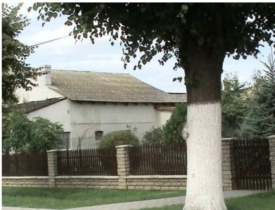
Fot. 10. Budynek mieszkalny pokryty płytami cementowo-azbestowymi – Piotroniowice nr 14.
